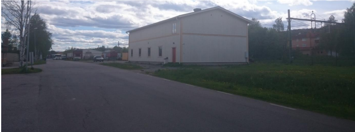
Planområdet, vy i sydlig riktning. Här, den norra delen, återfinns modernare byggnader.
