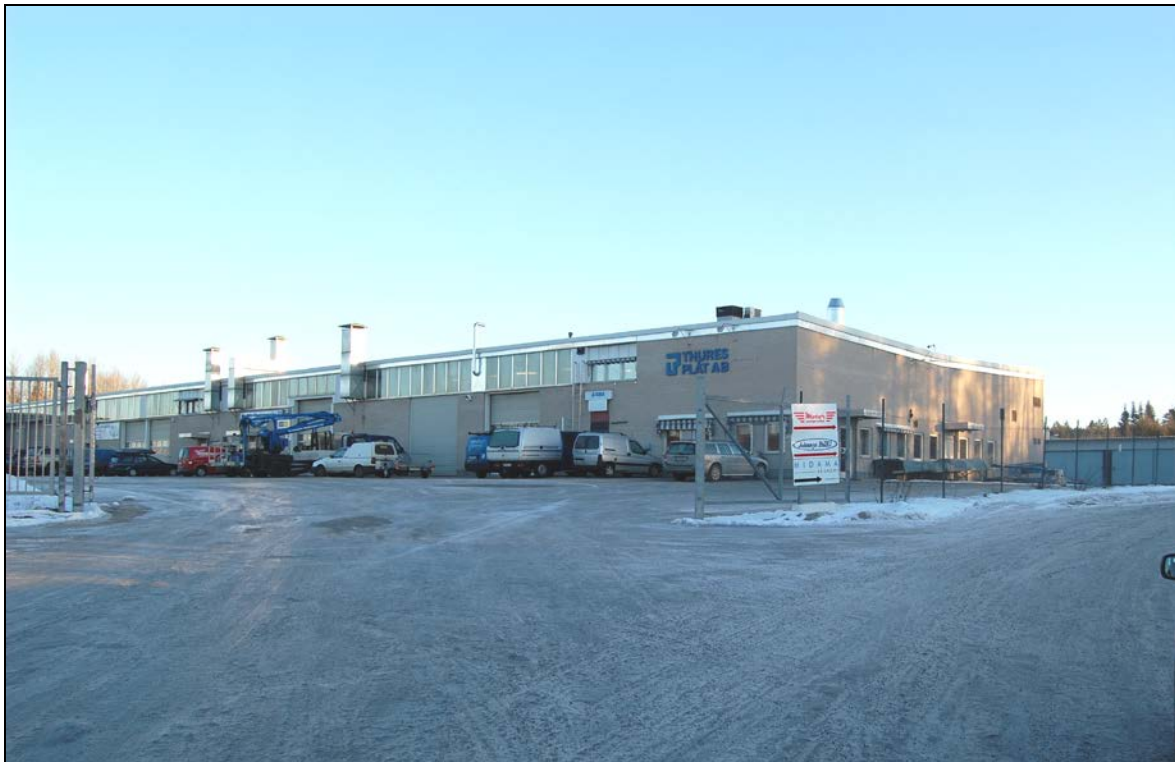
Kläppa industrihus vid Plåtslagargatan.
