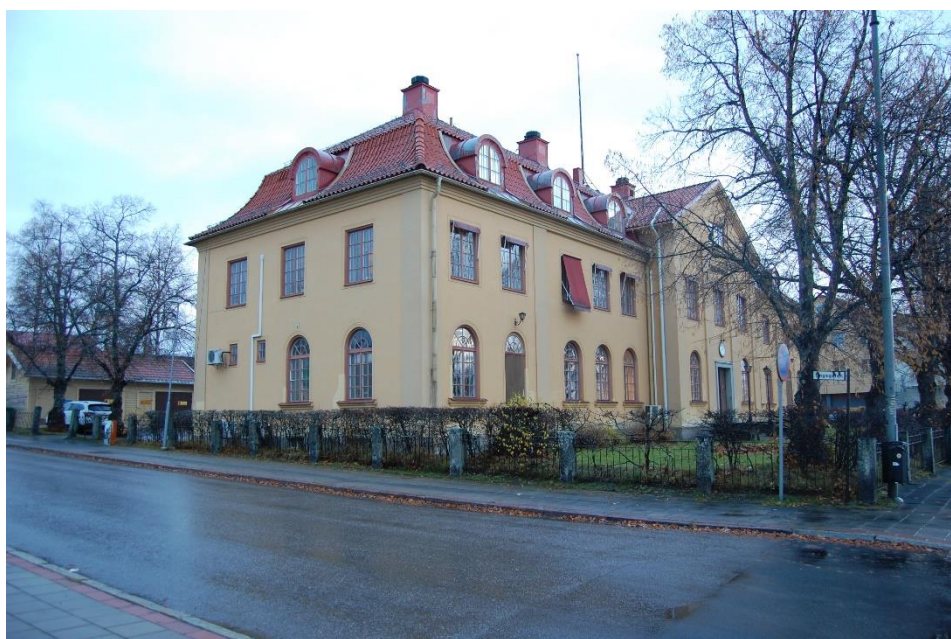
Figur 6. På fotot syns Tingshusets konkava mansardtak och fönstersättning. Fasaden har ljusputsade fasader i en gul ton. Taket har rött lertegel med fönsterkupor i röd plåt. Alla dessa karaktärsdrag ska bevaras (Foto: Ljusdals kommun, 2022-10-27).
