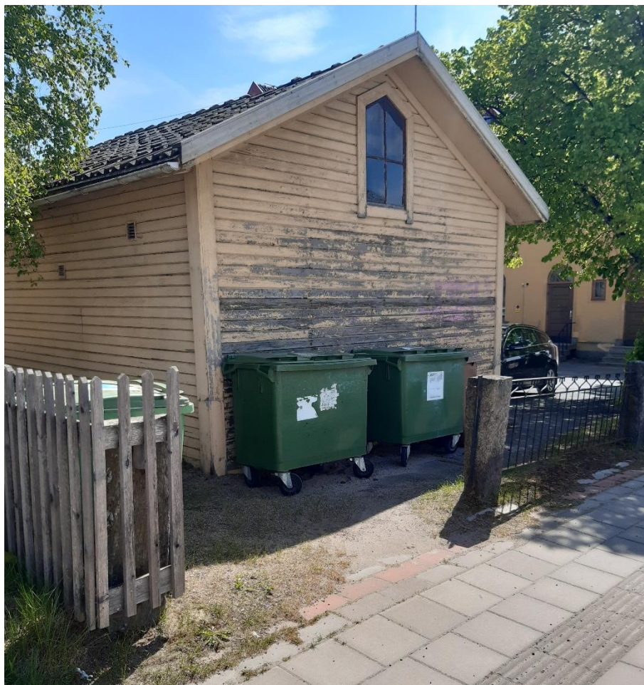
Figur 8. Nuvarande avfallslösning inom fastigheten Tälle 12:1 (Foto: Ljusdals kommun, 2023-05-30).
